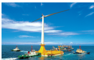
洋上風力発電施設の建設風景 出典：株式会社グローバル
