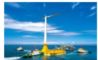
洋上風力発電施設の建設風景 (写真の出典元：ひびきフローティング ウィンドパワー合同会社)
