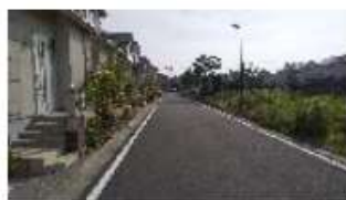
路側帯の設置された道路
